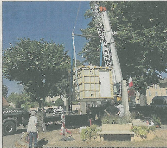
■ Les travaux d'installation du distributeur à la place Freihalden, en septembre 2018. Photo d'archives Megann STEPHAN
