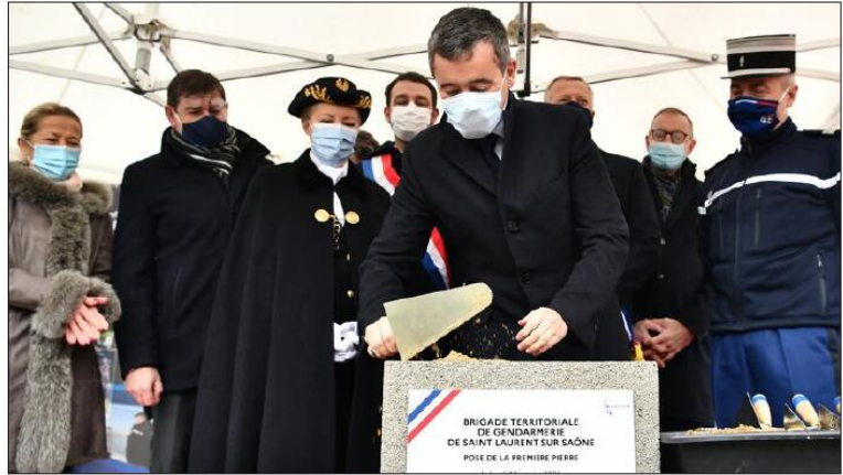
Gérald Darmanin, le ministre de l'Intérieur, a posé de la première pierre de la future gendarmerie de Saint-Laurent-sur-Saône ce lundi. Une fois le document signé, il est emballé puis sera enfoui dans les moellons.
